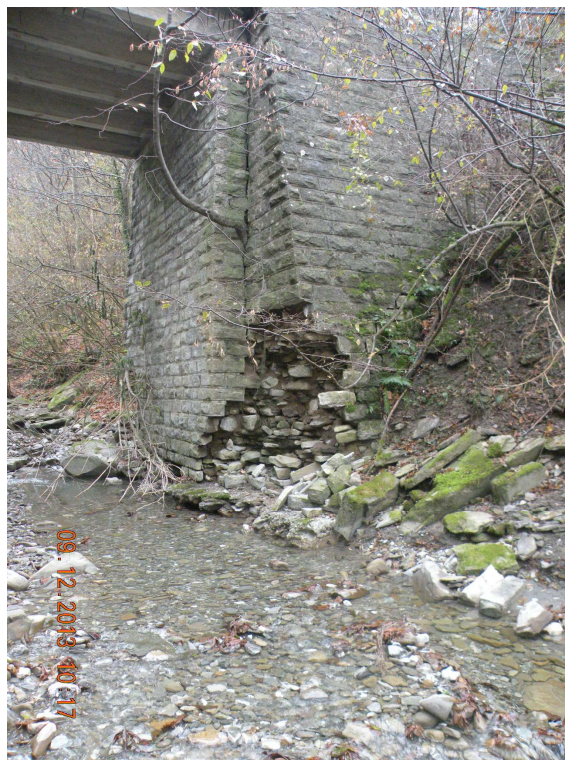
ANCHE LA PARTE IN USCITA DI DETTA SPALLA PRESENTA UN VISTOSO INIZIO DI SVUOTAMENTO.
