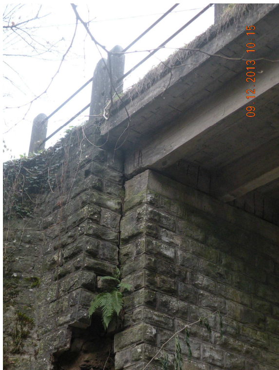
PARTICOLARE DELL'APPOGGIO DELLA SOLETTA IN C.A. CHE RISULTA ESSERE LESIONATO
