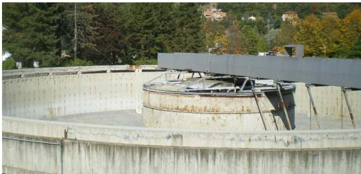
**Figura 1** - Impianto di depurazione a pianta circolare (sedimentatore)
