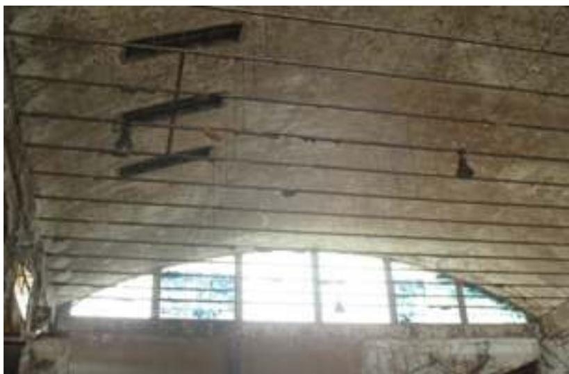
**Figura 5** - Immagine del rivestimento interno dell'edificio a volta (scortecciatura)
