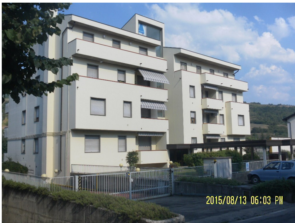
La facciata Ovest dell'edificio
