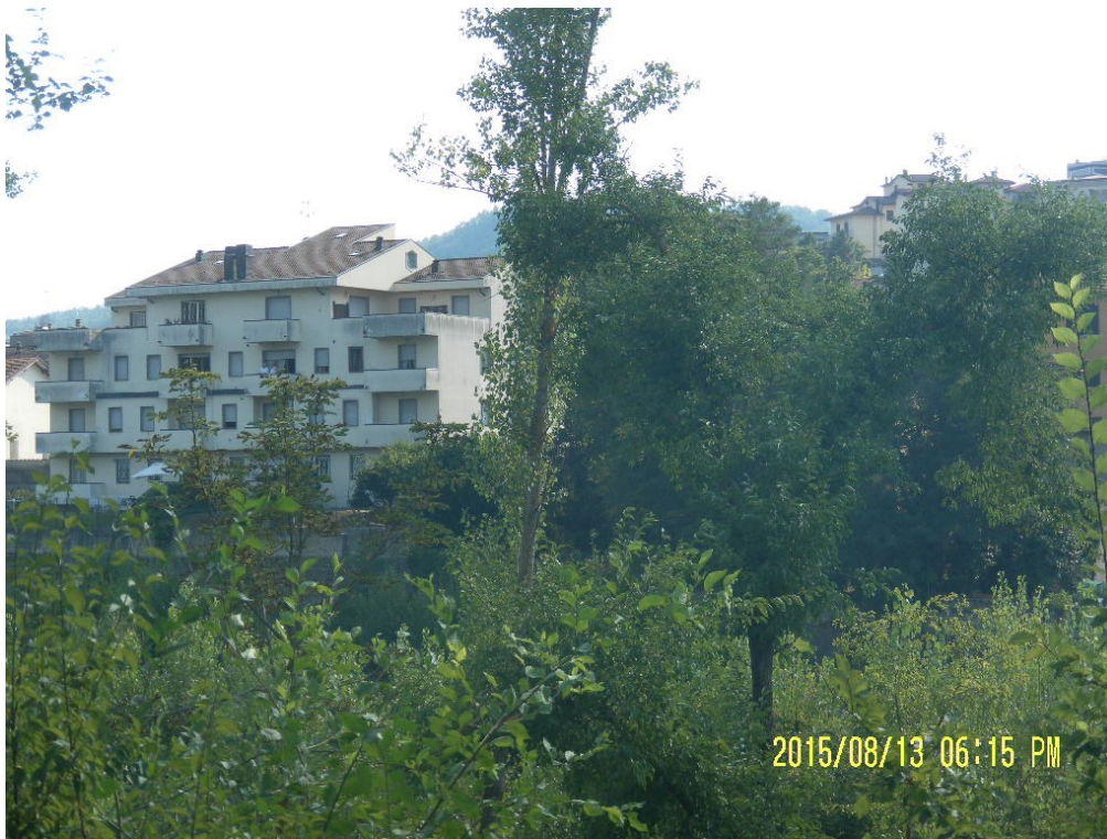
L'edificio visto sul lato Est dall'America di Grizzana Morandi
