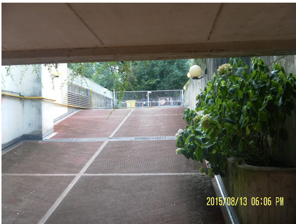
La rampa di accesso alle autorimesse
