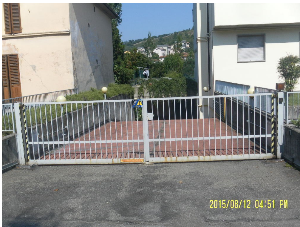
L'ingresso alle autorimesse con cancello ad apertura con telecomando
