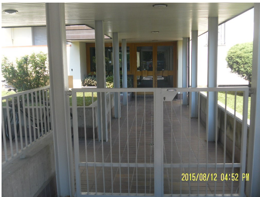
L'ingresso pedonale sulla Via A. Comani
