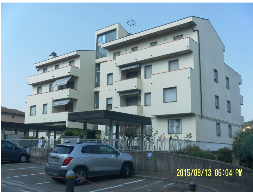
La facciata Ovest dell'edificio
