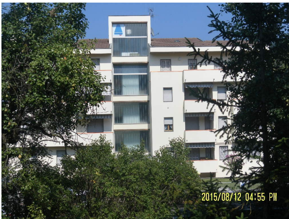
L'edificio visto da Via della Costituzione
