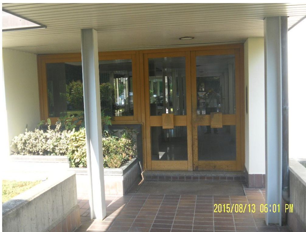
L'ingresso al vano scale
