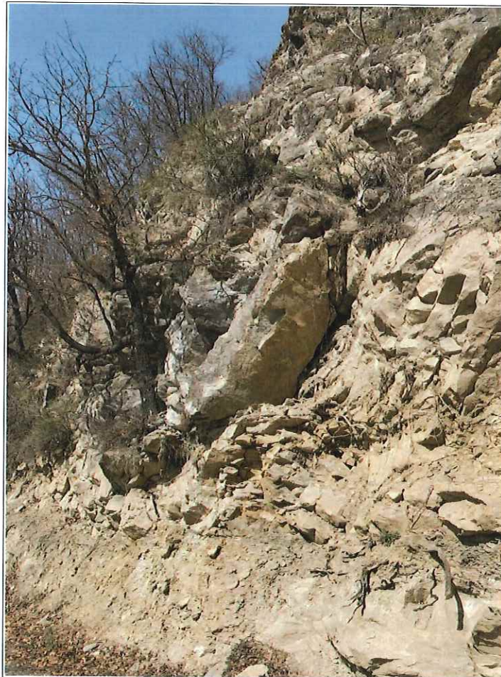
Vista laterale del blocco instabile
